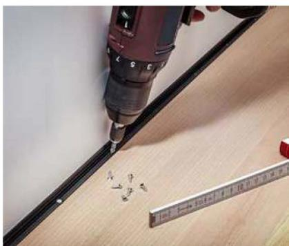
4. Anschrauben (Spanplattenschraube Senkkopf 2,5x10) – optional
